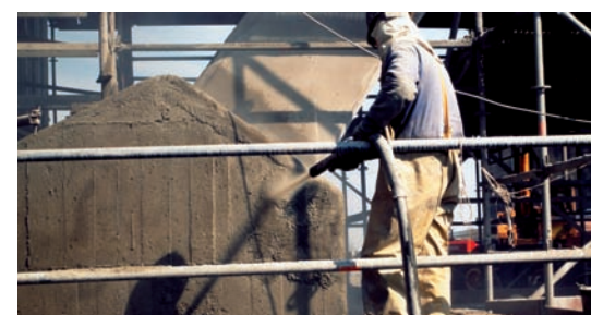
1. Локальный ремонт бетона
