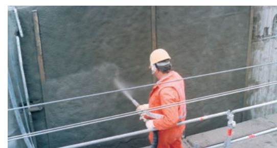
2. Увеличение защитного слоя бетона
