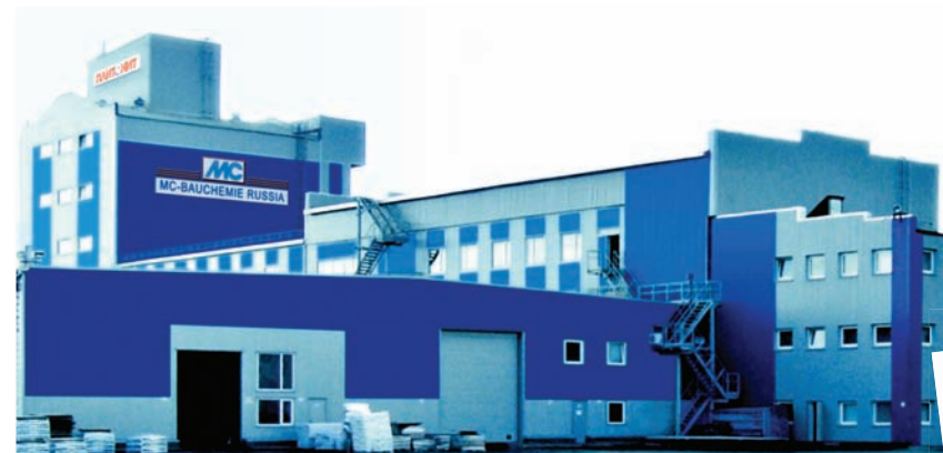
Завод MC-Vauchemie Russia, г. Кировск, Ленинградская обл.
